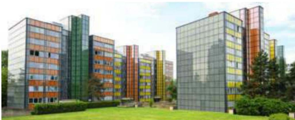
**Die Wohnbauanlage in Graz-Liebenau wurde 2014 auf Passivhausniveau saniert. Der gesamte Energiebedarf (Heizung + Warmwasser) konnte von 158,09 auf 18,15 kWh/m<sup>2</sup>/a reduziert werden**
